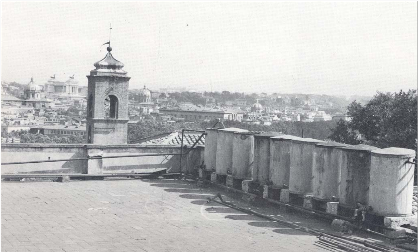
fig. 2 Erogazione a "luce tarata" con serbatoi domestici (cassoni) – Roma - tratta da “Acque e acquedotti a Roma 1870-1984” di G. Coppa, L. Pediconi e G. Bardi –edizioni QASAR
